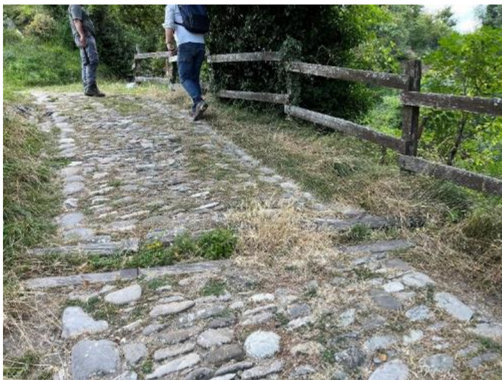
Foto 10 – canalette esistenti lungo la strada acciottolata che conduce al castello
