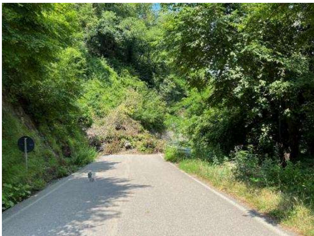
Foto 1 – vista dell'accumulo di frana sulla Strada provinciale, attualmente chiusa al traffico
