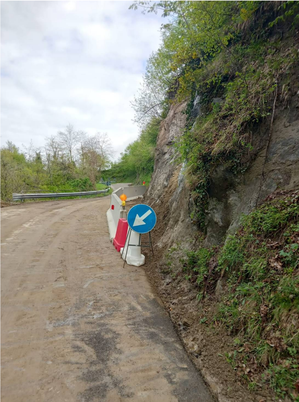
Foto 5 - vista della SP 76 al km 1+680 con barriera in new jersey e restringimento della carreggiata stradale
