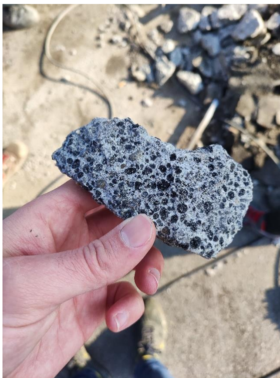
Soletta in calcestruzzo alleggerito rinvenuta durante fasi di diagnostica
