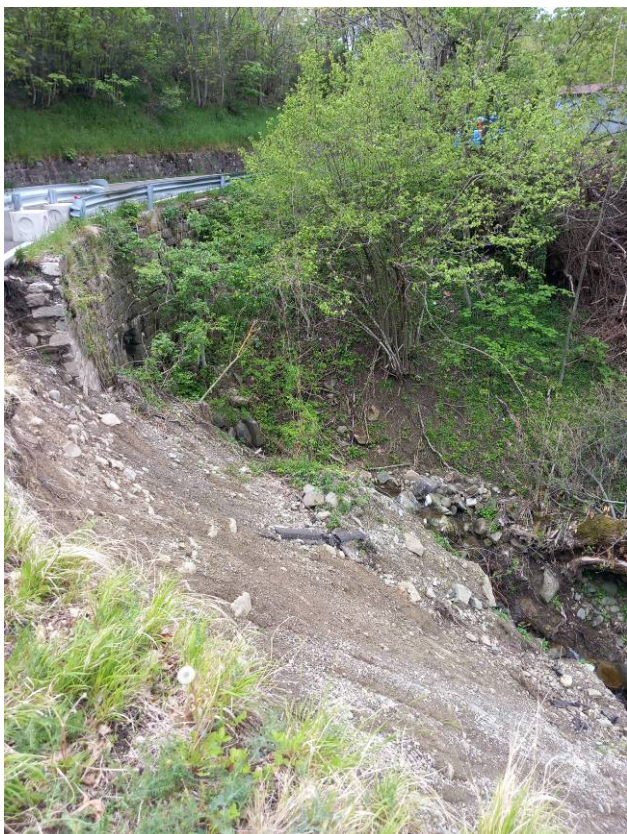
Foto 6 - vista del dissesto del versante di valle e del muro in sasso esistente
