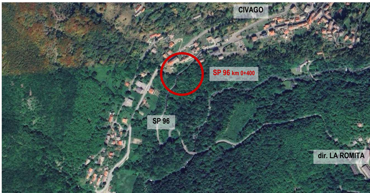
Figura 1 – vista aerea della SP 96 con individuazione dell'area oggetto di intervento
