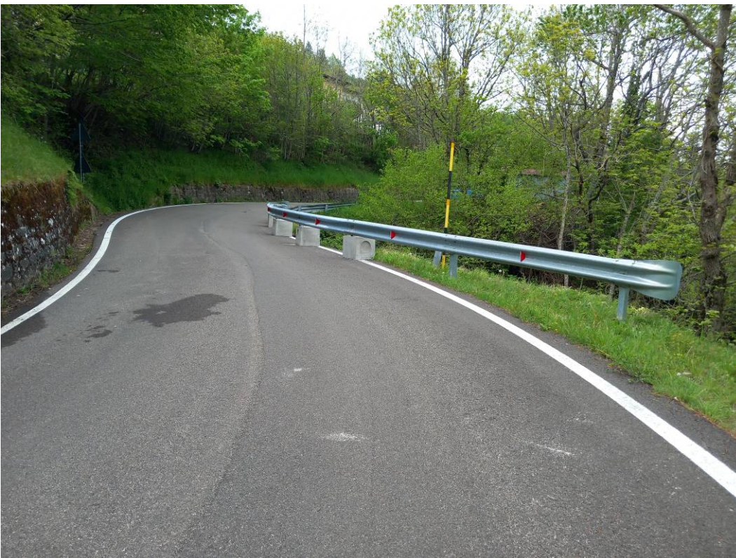
Foto 3 - vista della SP 96 nel tratto interessato dal dissesto della scarpata di valle, con installata la barriera temporanea
