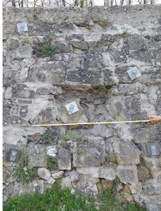
**Foto 5 – vista del muro sottoscarpa con crolli e perdita di conci ed erosione dei giunti**
