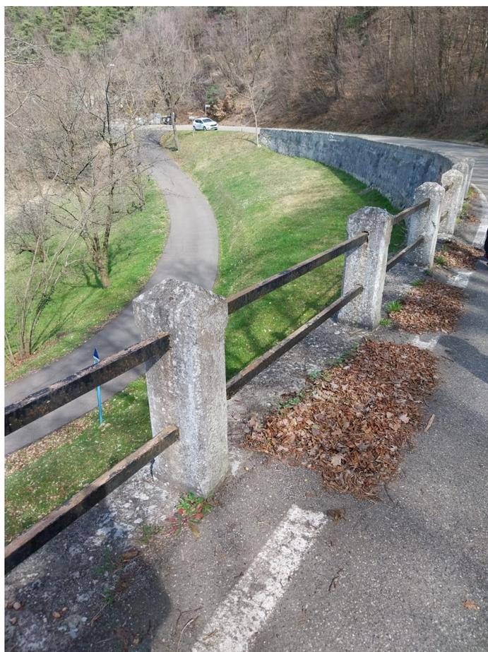
**Foto 8 – vista della barriera bordo ponte esistente non a norma**
