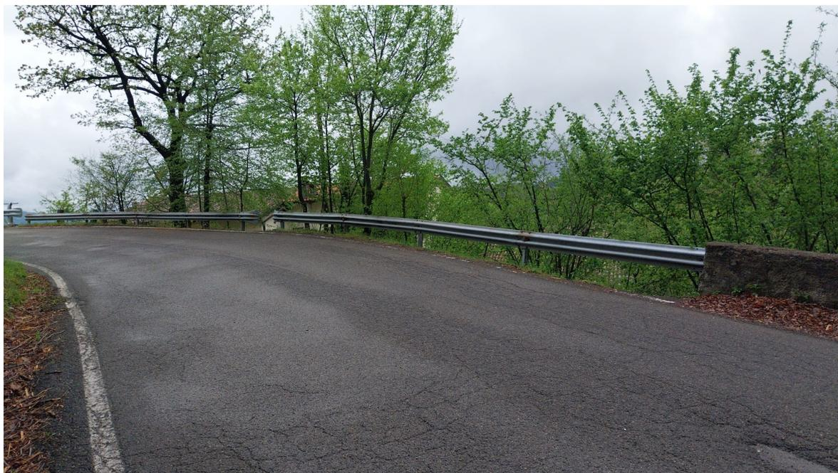
Foto 10 – vista della barriera laterale esistente non a norma
