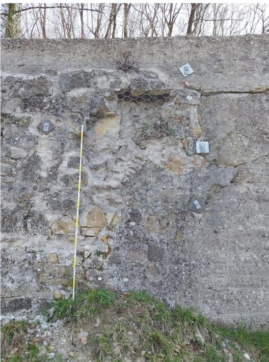
**Foto 4 – vista del muro sottoscarpa con crolli e perdita di conci ed erosione dei giunti**
