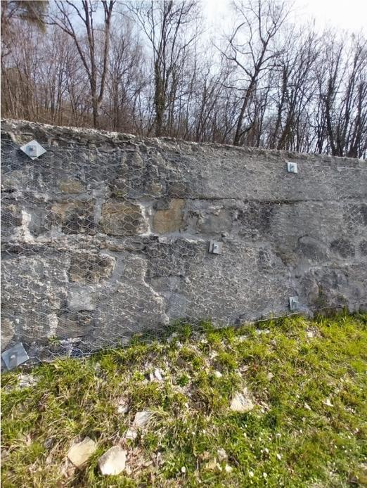
**Foto 3 – vista del muro sottoscarpa con crolli e perdita di conci ed erosione dei giunti**
