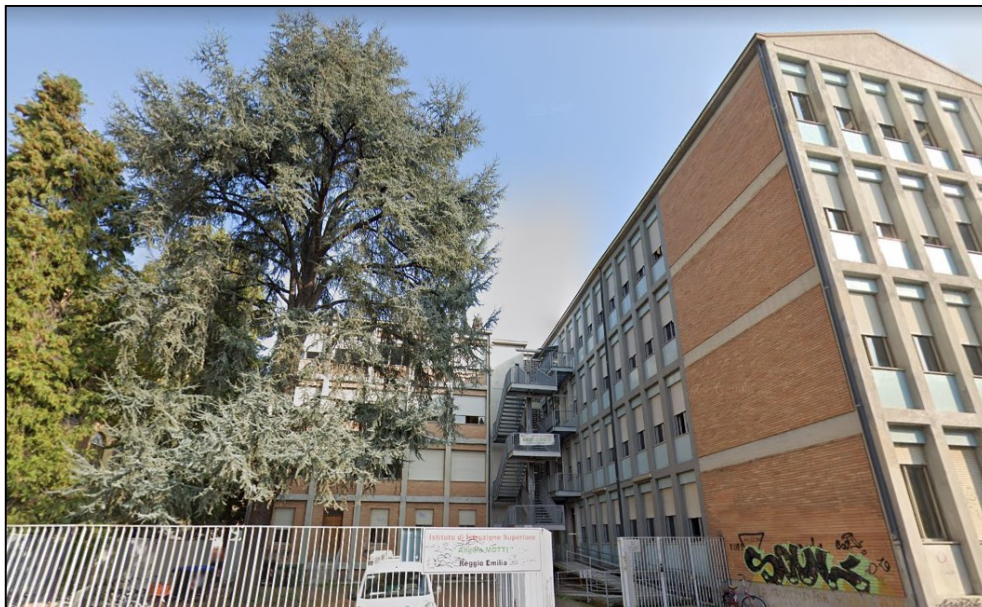
fig. 3.31 – Facciata del corpo scuola – via Filippo Re
