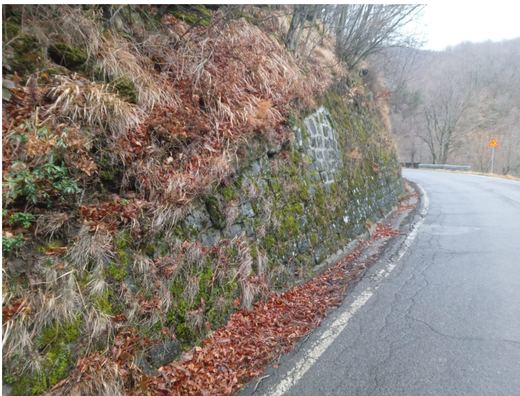
Foto 9 - vista del muro di monte (muro F), Intervento 04
