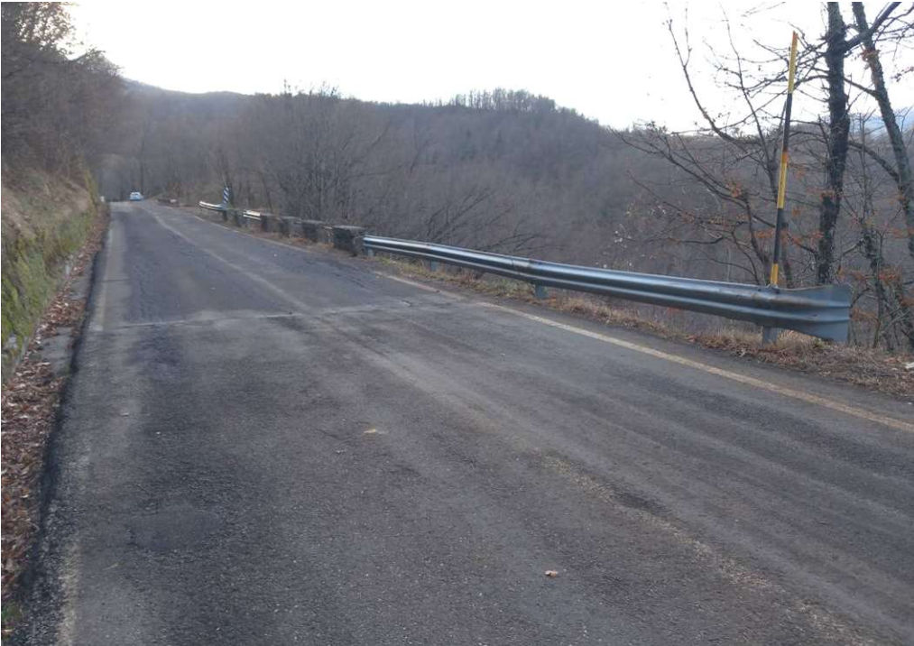
Foto 1 – vista del tratto stradale e dei sistemi di ritenuta in corrispondenza del muro A, Intervento 01
