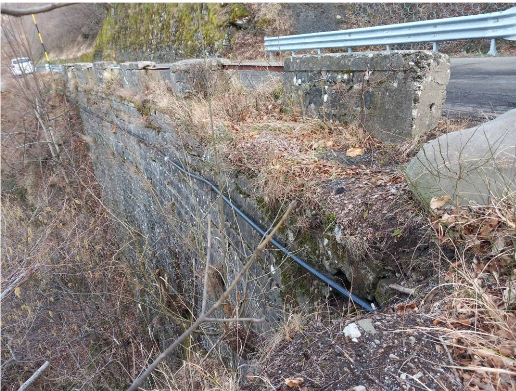
Foto 4 - vista dei sistemi di ritenuta e del muro B, Intervento 02
