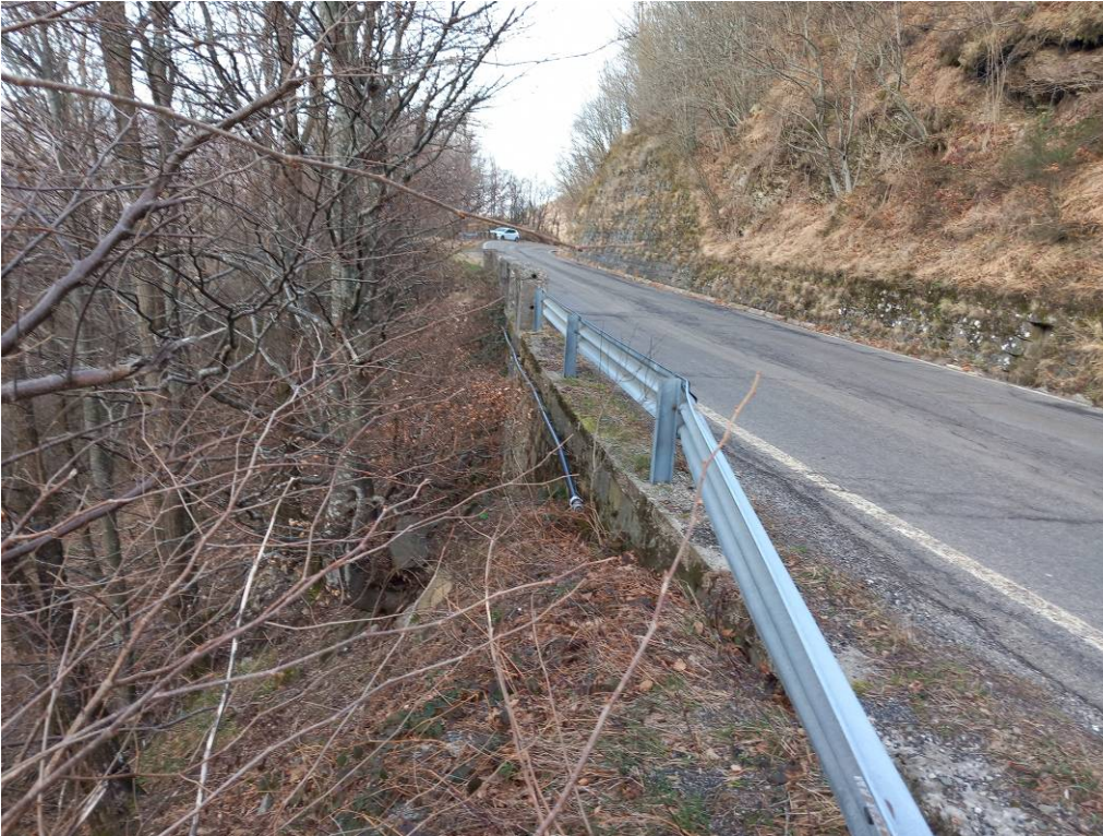
Foto 7 - vista dei sistemi di ritenuta e del muro D, Intervento 03
