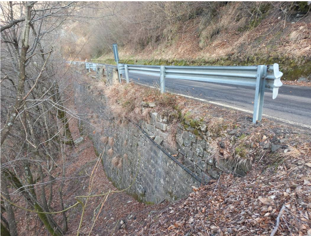
Foto 2 - vista dei sistemi di ritenuta e del muro A, Intervento 01
