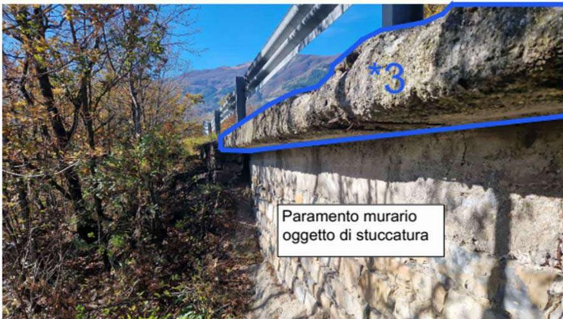
Figura 12 – Schema della soluzione progettuale ipotizzato per il manufatto di cui al punto c)
