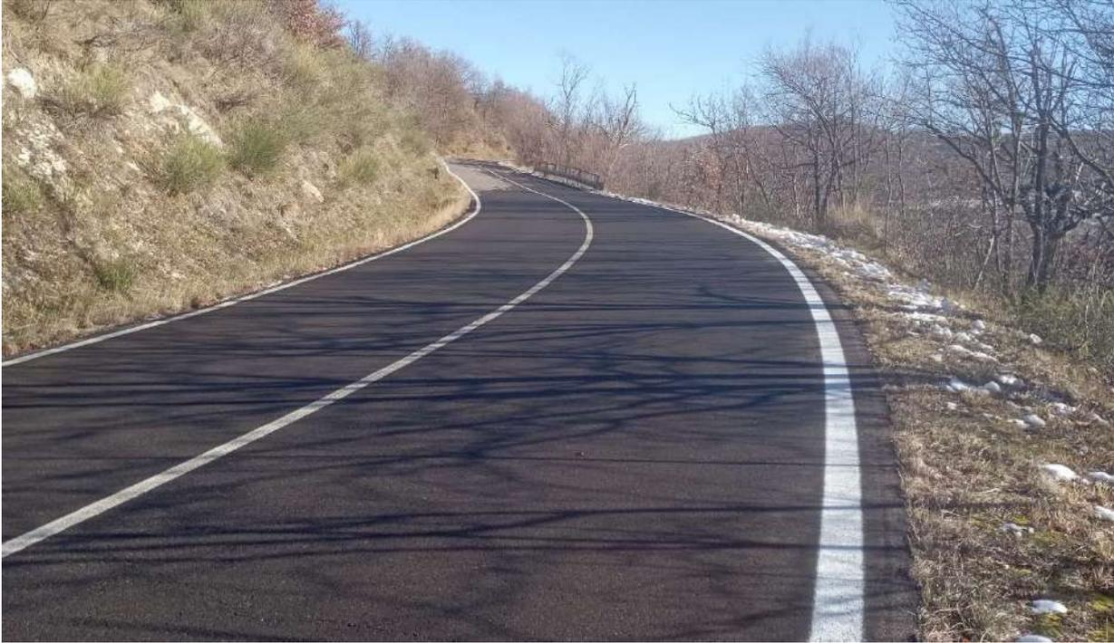
Foto 12 – Intervento H - Km. 24+380 – Area oggetto di posa barriera stradale e riqualificazione piano viario con asfaltatura
