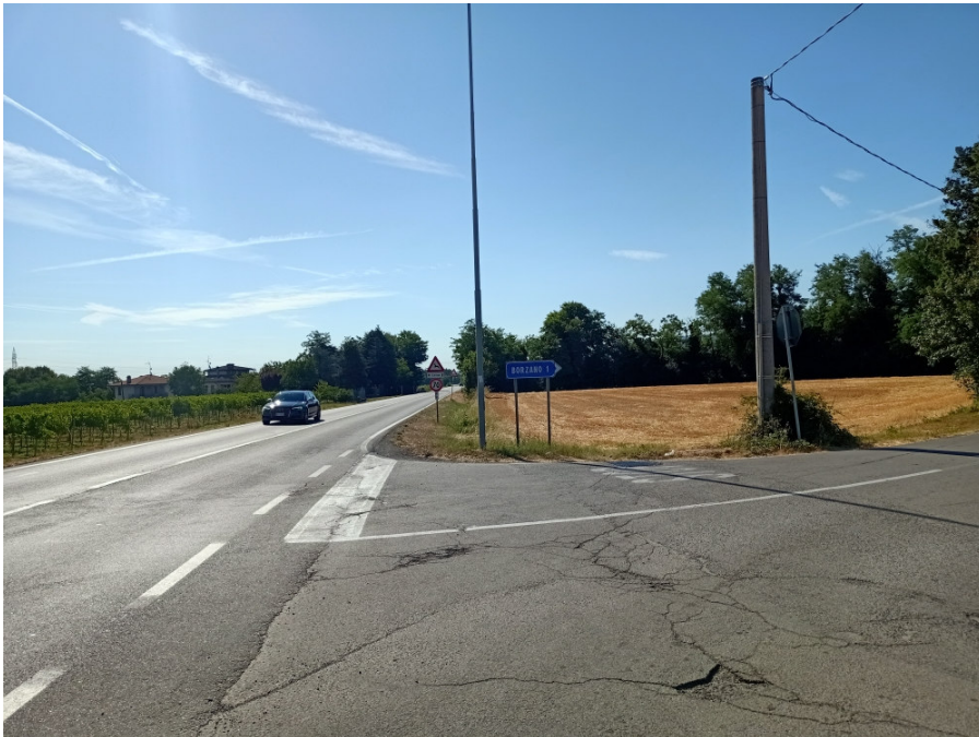
SP 37 DIREZIONE SCANDIANO DA INCROCIO VIA MONTANRA LATO SUD
