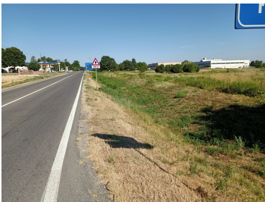
SP 37 DIREZIONE ALBINEA DA INCROCIO VIA MONTANARA LATO NORD
