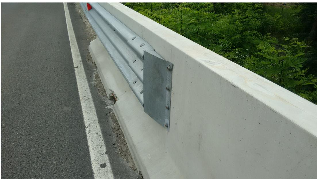
Analogamente, per quanto riguarda i collegamenti con la barriera preesistente a doppia onda, dovrà essere installato idoneo elemento di transizione a norma, per evitare la presenza di situazioni di discontinuità che risulterebbero estremamente pericolose.
