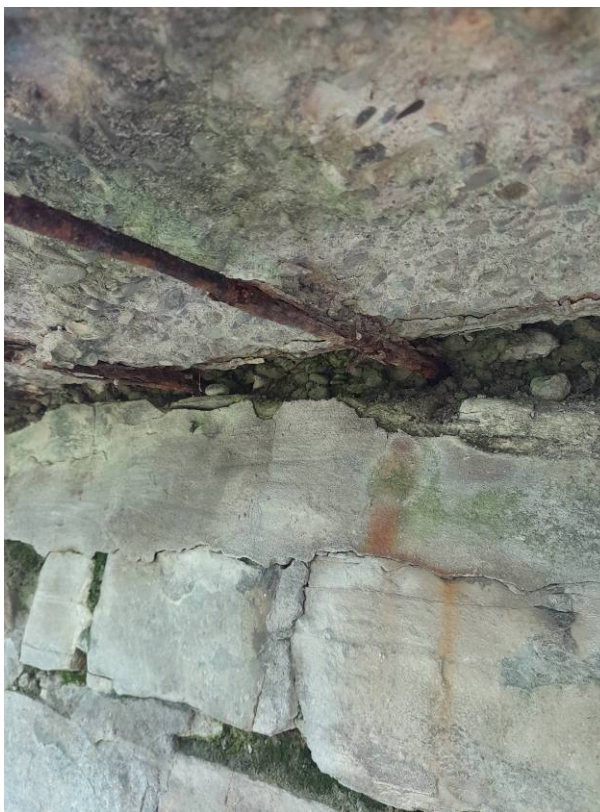
Foto 11 – vista del muro sottoscarpa lato Villa Minozzo, con erosione dei giunti e disgregazione del calcestruzzo del cordolo ed ossidazione dell'armatura
