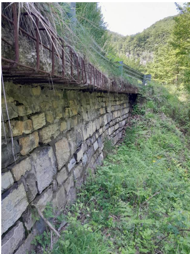
Foto 11 – vista del muro sottoscarpa lato Villa Minozzo, con erosione dei giunti e disgregazione del calcestruzzo del cordolo ed ossidazione dell'armatura
