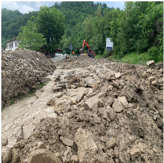
Foto 3 – 04 giugno 2023 - Vista del punto in cui si è verificata l'ostruzione dell'attraversamento stradale con a lato il materiale proveniente dal fosso di scolo acque pubbliche
