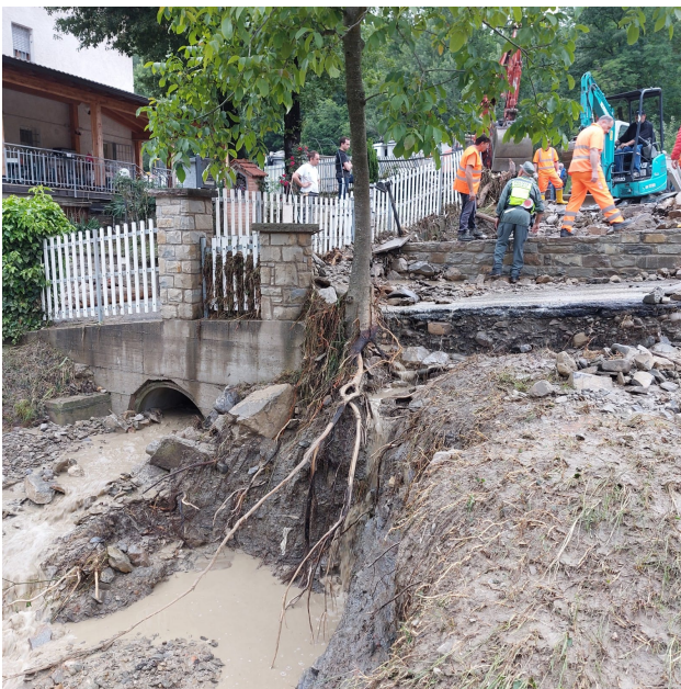
Foto 3 – 04 giugno 2023 - Vista del punto in cui si è verificata l'ostruzione dell'attraversamento stradale con a lato il materiale proveniente dal fosso di scolo acque pubbliche
