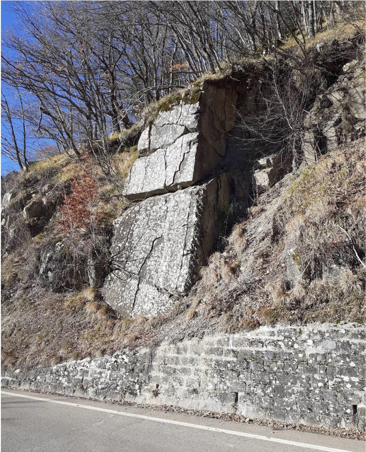
**Foto 3 – Vista del blocco roccioso in scarpata all'avvio della curva stradale in direzione Civago, con evidenza dell'elevato grado di fatturazione e dell'instabilità di diversi porzioni e frammenti.**
