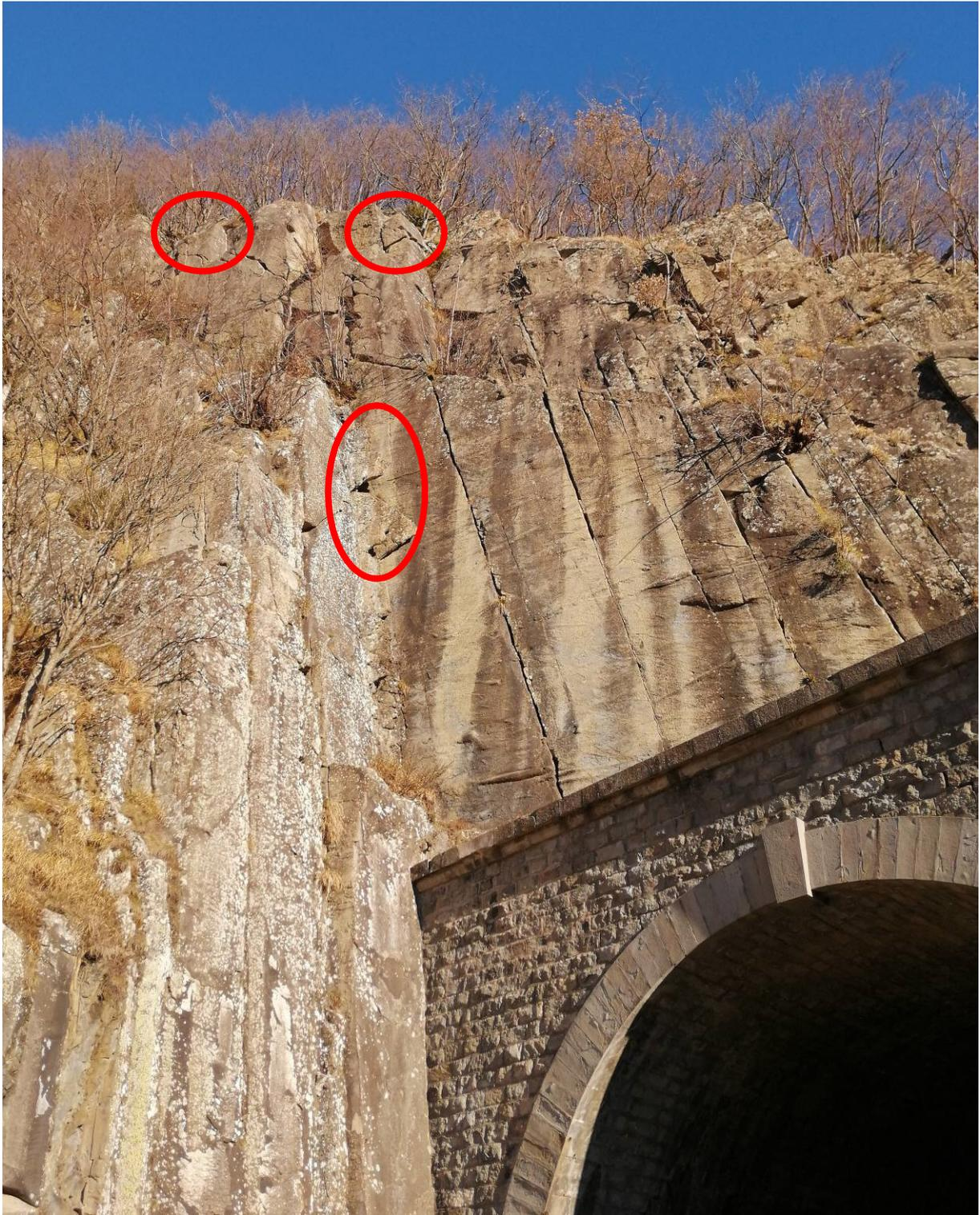
**Foto 2 – Vista del manufatto in muratura dell’imbocco sud della galleria, particolare delle pareti rocciose sovrastante e laterale della galleria a monte della Strada Provinciale, con evidenza dei piani principali di fratturazione dei fronti rocciosi, ad andamento pressoché verticale. Si evidenziano le porzioni ed elementi rocciosi particolarmente instabili lungo le pareti.**
