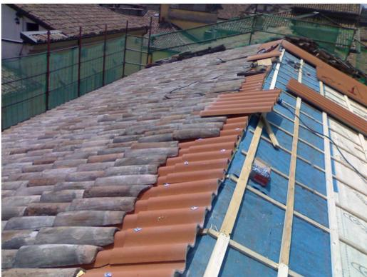
rifacimento manto di copertura mediante l'accurata messa in opera dei coppi precedentemente accatastati, oppure in sostituzione di quelli ammalorati o rotti con coppi usati (e relativi pezzi speciali) di recupero da altri cantieri.
