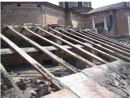
demolizione e rimozione di copertura a tetto in tavelle di laterizio;
