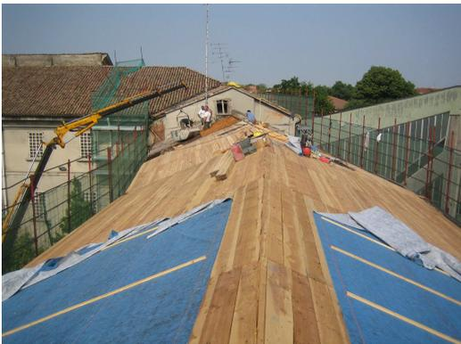
fornitura e posa in opera di tavolato ligneo per formazione di sottanto di copertura e listello in legno 4x4 cm. adeguatamente fissato alla struttura sottostante;
