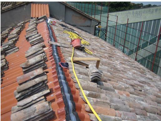
sistemazione linee di colmo con fornitura e posa di elemento sottocolmo per tetti ventilati.
