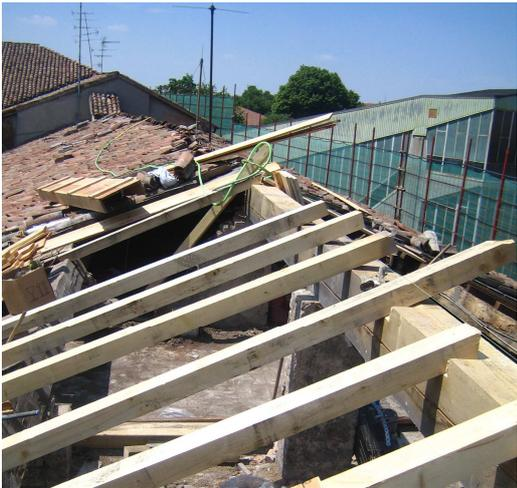
fornitura e posa in opera con sostituzione e/o rinforzo di alcuni elementi della piccola e/o media orditura ammalorata non recuperabile mantenendo il medesimo disegno strutturale.
