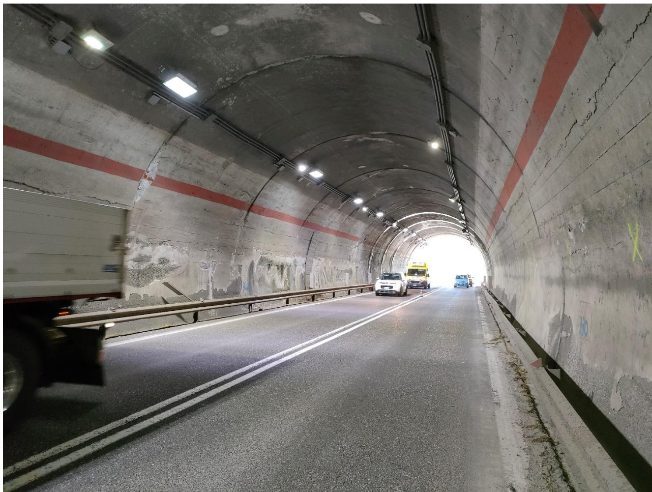
Figura 2 - Vista della galleria
