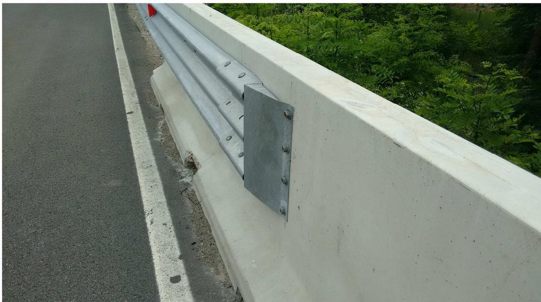
Analogamente, per quanto riguarda i collegamenti con la barriera preesistente a doppia onda, dovrà essere installato idoneo elemento di transizione a norma, per evitare la presenza di situazioni di discontinuità che risulterebbero estremamente pericolose.
