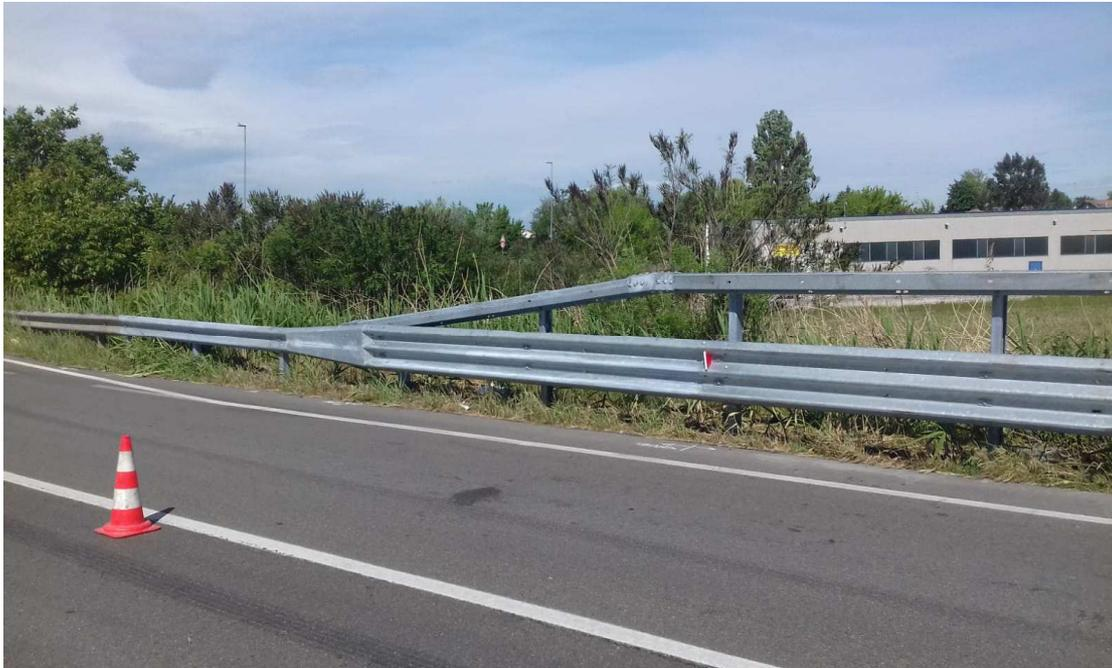
La barriera bordo laterale dovrà essere stata testata con pali infissi in un terreno con caratteristiche assimilabili a quelle del terreno ove le barriere stesse andranno installate.
