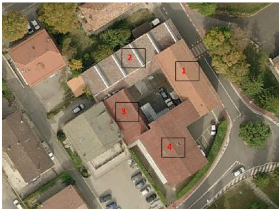
Figura 1.1: Veduta d'insieme del complesso scolastico
