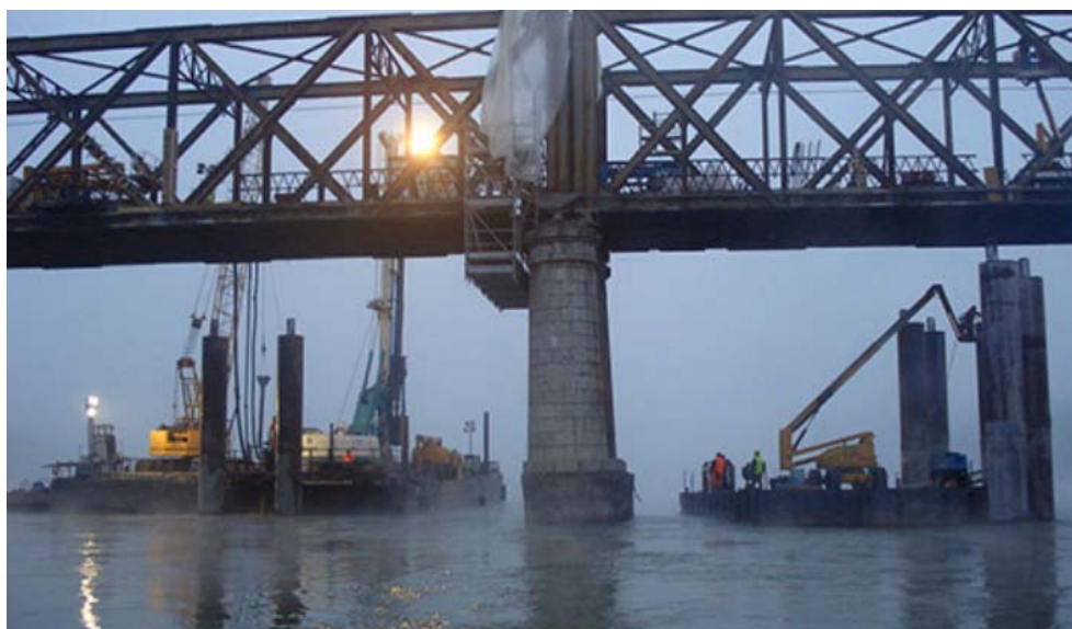
Figura 36 – foto con esempio di impiego di pontoni in ambito fluviale per intervento su ponte esistente
