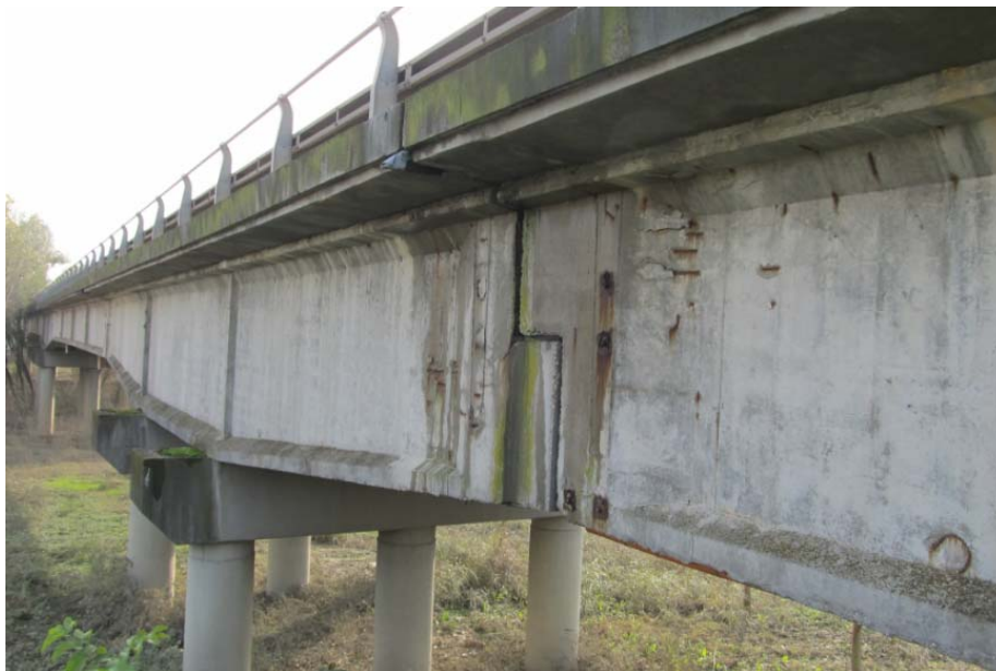
Figura 7 – ingrandimento su mpalcato precompresso - tratto in provincia di Mantova
