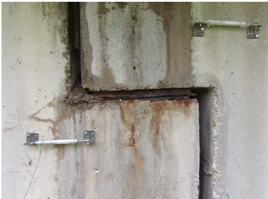
Figura 26 – foto di un appoggio presente sul tratto in golena lato MANTOVA (originario)
