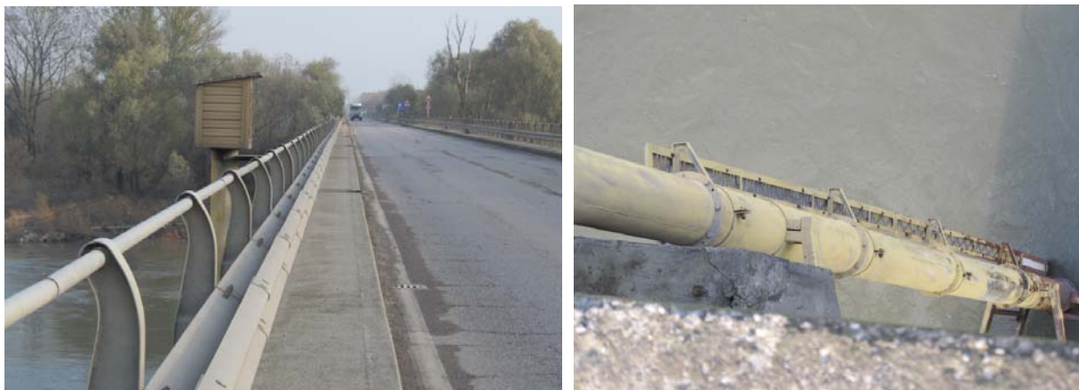
Figura 30 – idrometro AIPO presente sul lato di valle del ponte, al centro dell'alveo di magra
