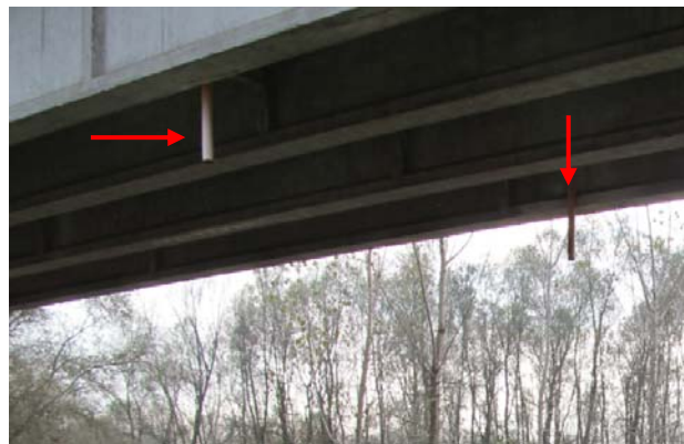
Figura 13 – caditoia con griglia in ghisa esistente (foto sx), tubazioni di scarico delle caditoie (foto dx)
