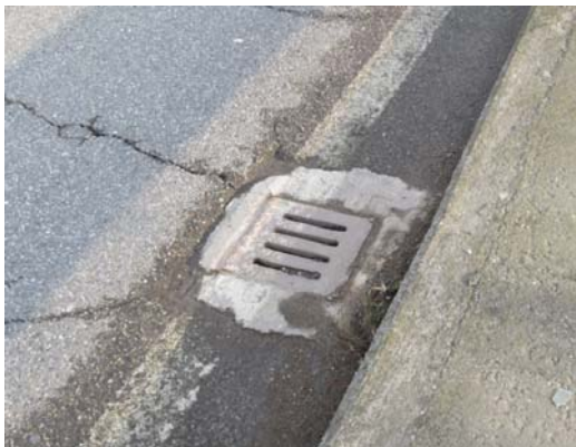
Figura 13 – caditoia con griglia in ghisa esistente (foto sx), tubazioni di scarico delle caditoie (foto dx)
