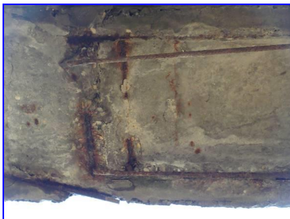
Degrado delle selle Gerber
