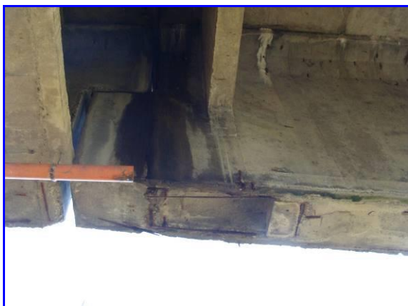
Degrado delle selle Gerber
